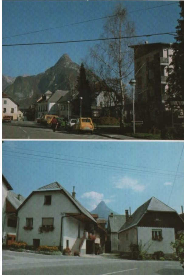
Slika 5: Razglednica Bovca. Na spodnji sliki je del Male vasi, visoke stavbe v ozadju - Adelčeve hiše ni več. (Vir: osebni arhiv Andreja Čopija)
